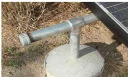
Fig. 25 - Picioar de susținere pentru un sistem fotovoltaic
