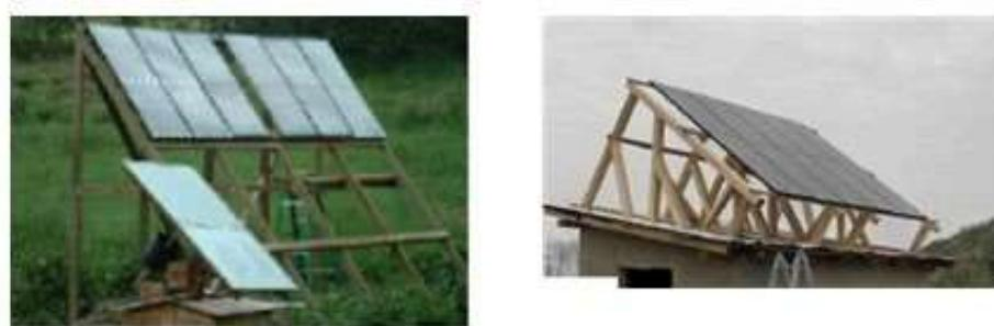
Fig. 23. Structuri de lemn pentru montarea panourilor fotovoltaice la o locuință
