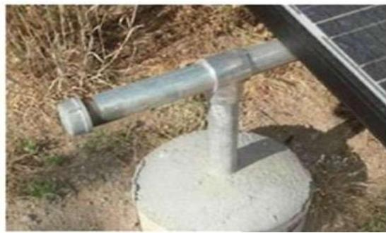
Fig. 25 - Picior de susținere pentru un sistem fotovoltaic
