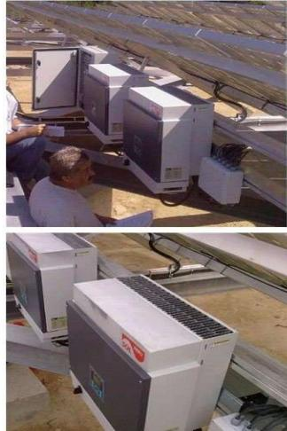
Fig. 19. Exemplu de montare în exterior a invertoarelor
