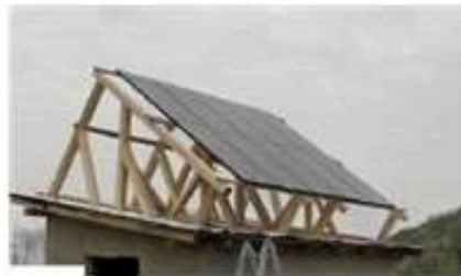
Fig. 23. Structuri de lemn pentru montarea panourilor fotovoltaice la o locuință
