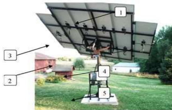
Fig. 33 - Tracker cu orientare după două axe montaj pe un pilon
