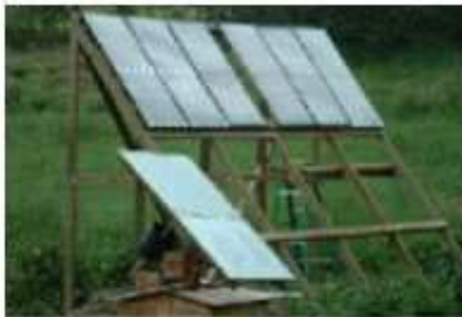
Fig. 23. Structuri de lemn pentru montarea panourilor fotovoltaice la o locuință
