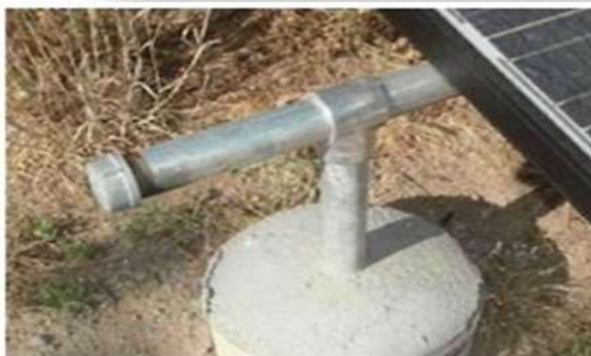
Fig. 25 - Picioar de susținere pentru un sistem fotovoltaic
